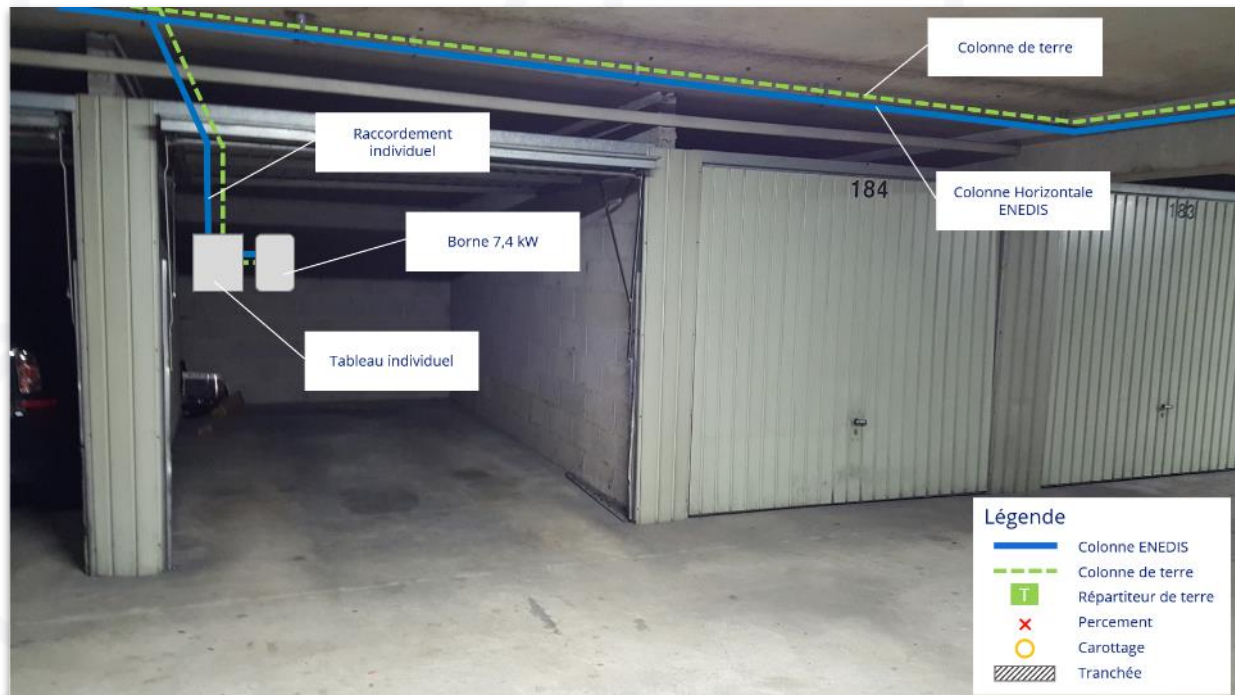
Photo avec schéma de raccordement individuel annoté
